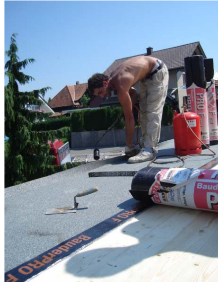
Verschweissen der Dachbahnen beim Kiesklebedach
