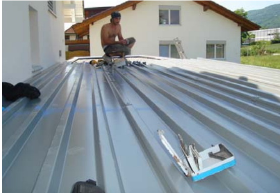
Montage Profilblechdach
