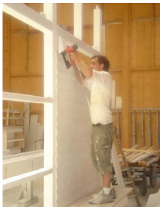
Vormontage der Wände in der Werkhalle
