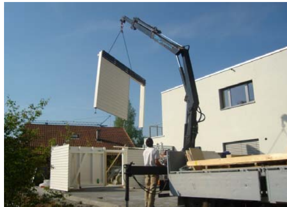
Montage Wand auf der Baustelle
