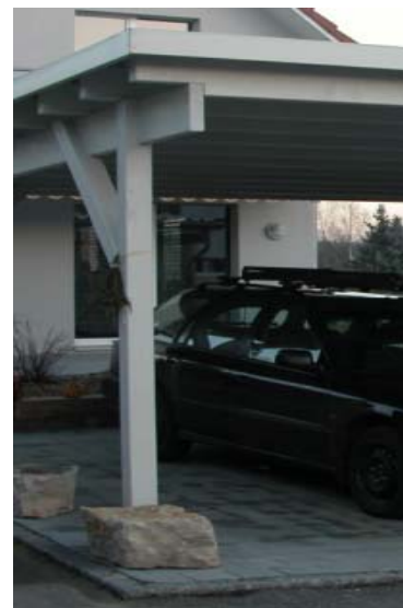
Beispiel eines Pfostens mit „Anfahrtschutz“
