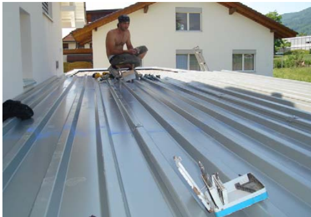
Profilblechdach bei der Montage.
