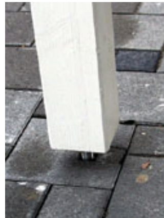
Nach der Montage
