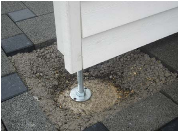
Fundament bei der Montage des Carports
