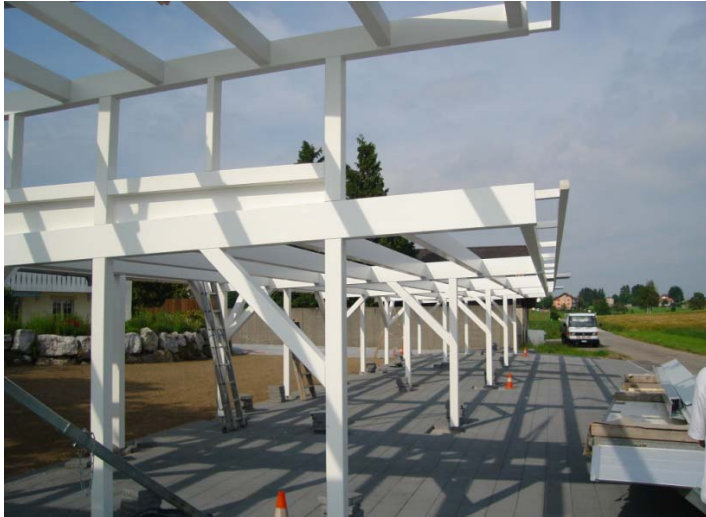
Profilblechdach Carport bei der Montage
