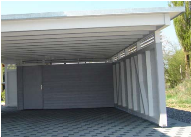
Wand Ansicht von innen, Riegwandkonstruktion
