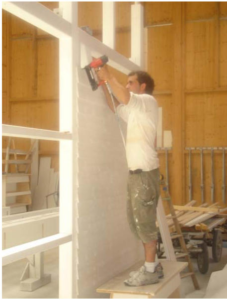
Montage der Stülpchalung
