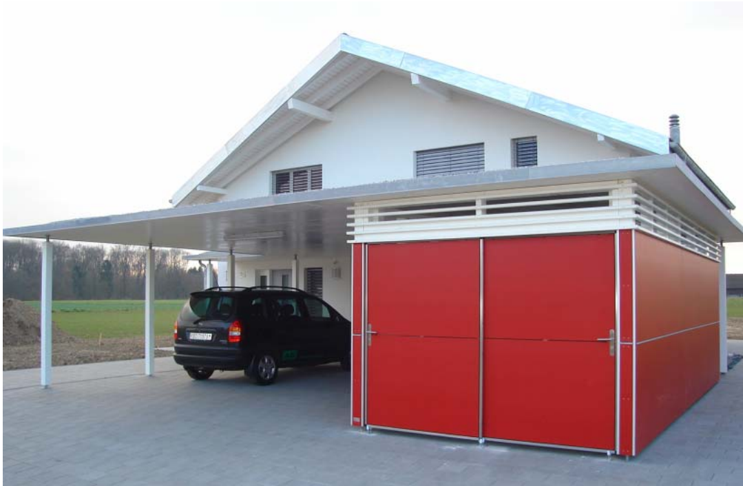
Veloraum bestens zugänglich dank zwei Formboard-Schiebetüren
