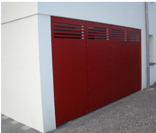
Formboardplatten-Wand mit Lüftungsschlitzen
