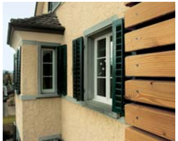
Die 29 Zentimeter dicken Holzrahmenelemente wurden in der Fabrik vorgefertigt; die Isolation ist aus Isofloc.
