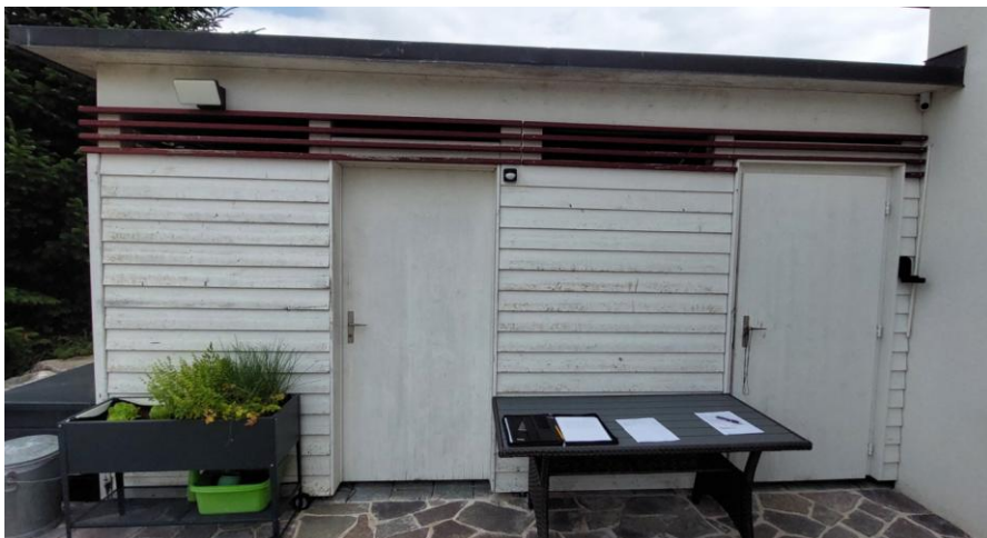
Paroi latérale abri voiture 17 ans sans traitement ultérieur.
