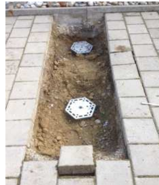
Einfache Montage mit Schraubenfundamente
