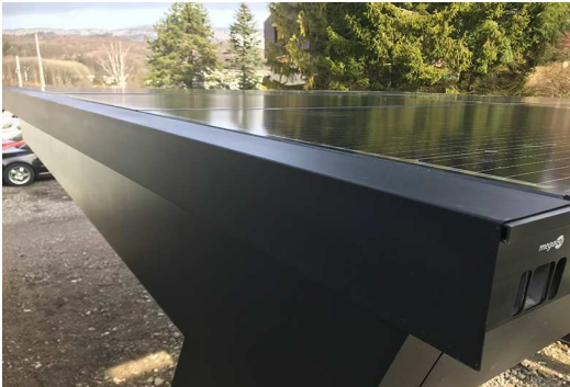
Dacheindeckung mit transluziden bifacialen Hochleistungsmodulen
