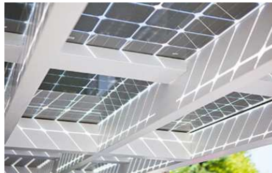
Dacheindeckung mit transluziden bifacialen Hochleistungsmodulen
