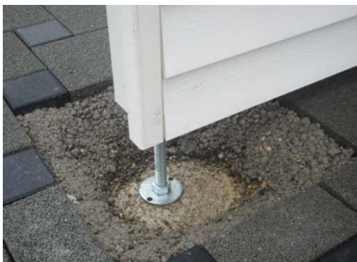
Fundament bei der Montage des Carports
