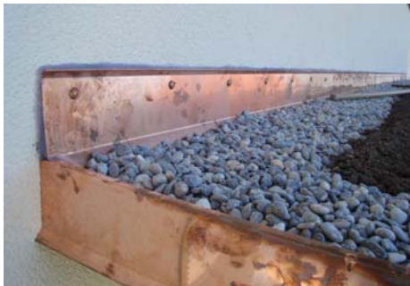
Wandanschluss und Dachrandabschlüsse in Kupfer
