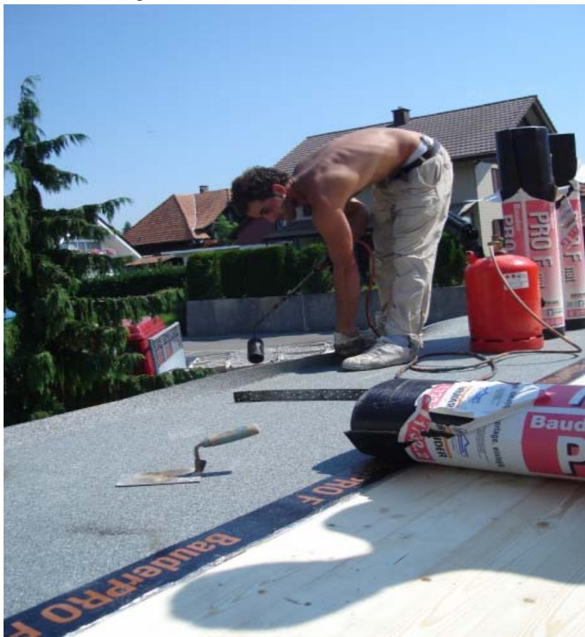
Verschweissen der Dachbahnen
