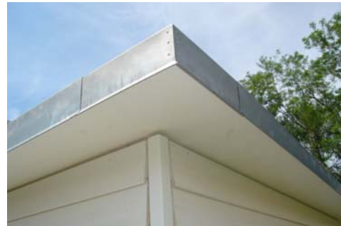
Dachrandabschluss in Titanzink
