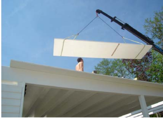
Verlegen der 3-Schichtplatten auf Balkenlage
