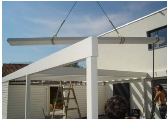
Montage der Balkenlage
