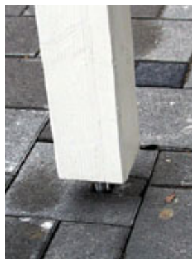
Nach der Montage
