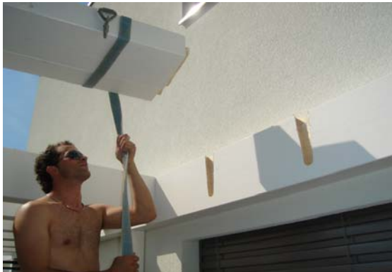
Balken mit Schwalbenschwanzverbindungen
