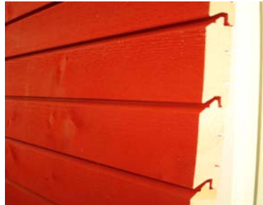
Geschlossene Rhomboidschalung mit Nut und Kamm
