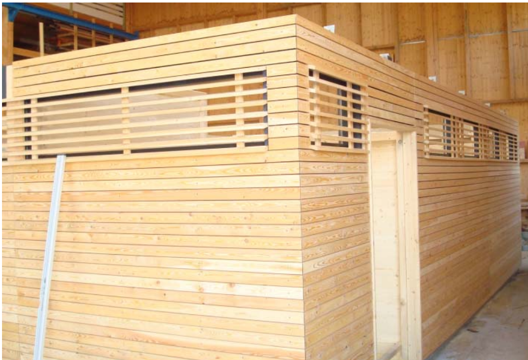
Schräg gestellte Rhomboid-Lamellen im Bereich der Oblichtfenster
