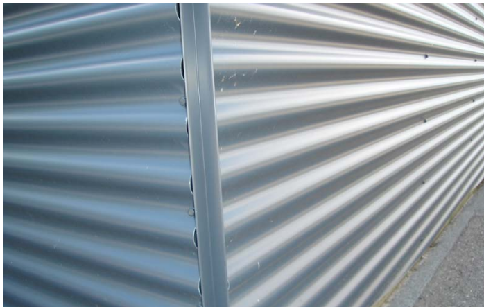
Eckdetail mit Kreuzeckblech
