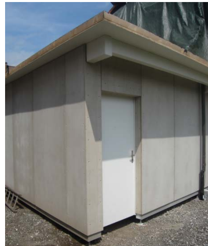
Garage vor den Auftrag des Verputzes
