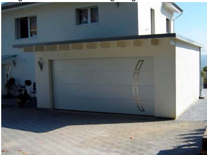
Garage fertig verputzt
