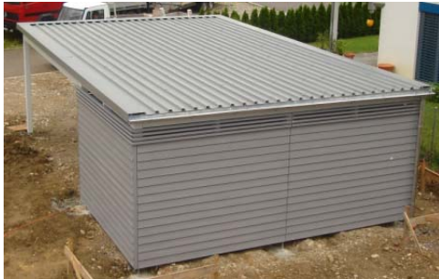
Drei Seiten mit Dachrandblenden, eine Seite mit Regenrinne
