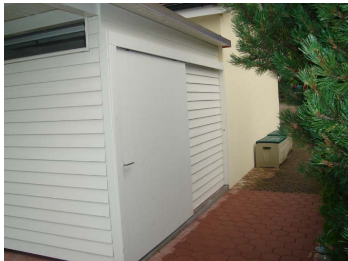
Schiebetür Aussen auf Wand montiert.
