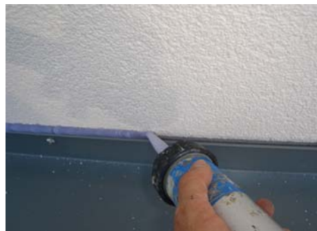
Anschluss mit Silikon abdichten
